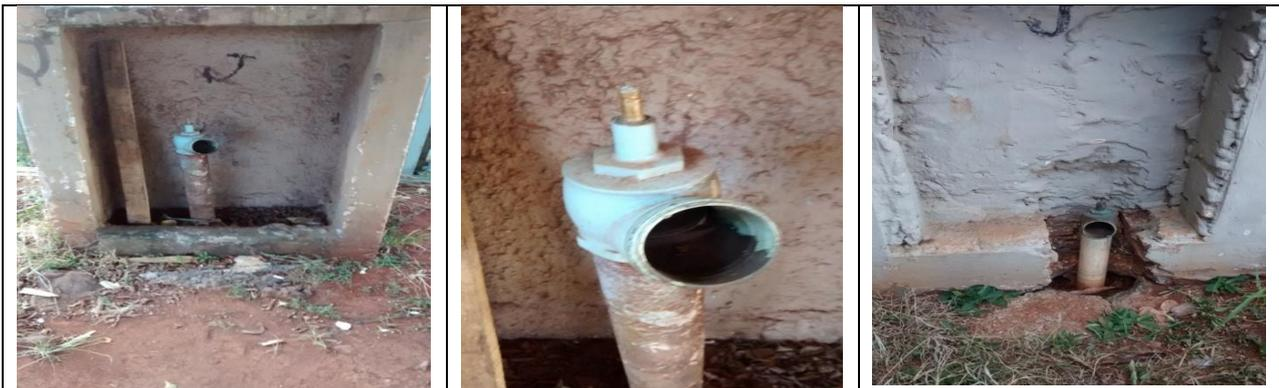
**Figura 1 – Equipamentos para combate a incêndio completamente vandalizados no Galpão B7-2**
