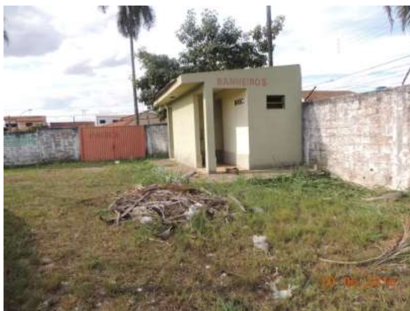
Foto: entulho próximo ao acesso aos banheiros
