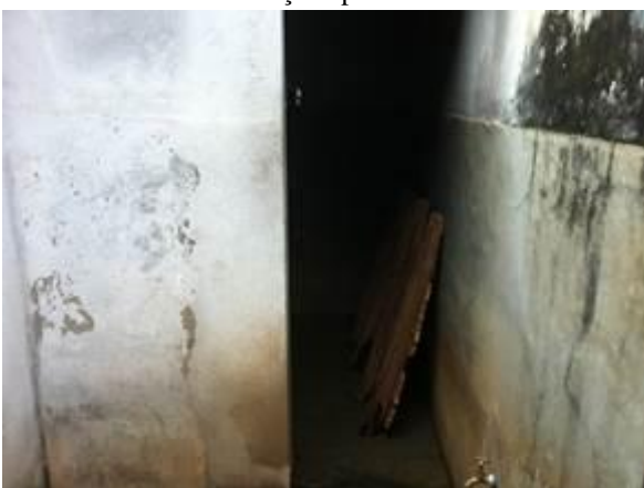
Baia não utilizada
