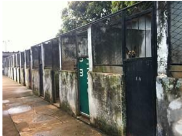
Portões dos canis – conserto com placas de trânsito
