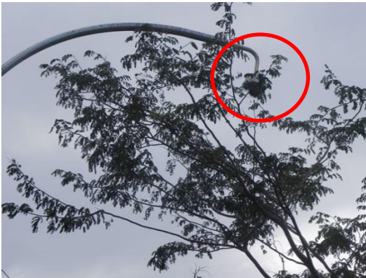
Figura 1 - Câmera obstruída pela vegetação. Local: Samambaia, próximo às quadras QS 112.
