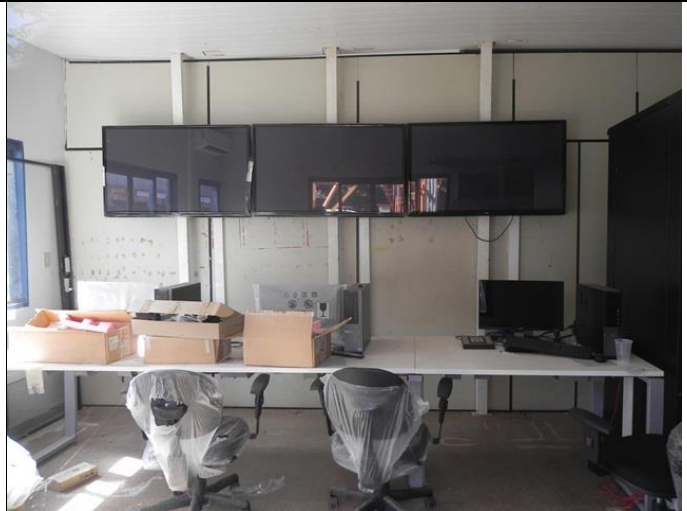
Figura 19 - Equipamentos desativados e ausência de equipe técnica responsável pela operação dos equipamentos.
