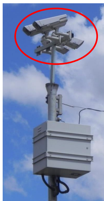
Figura 10 - Instalação de mais de uma câmera em apenas um poste. Local: Taguatinga BR 070, próximo à QNG 47. Registro fotográfico em 01/2016
