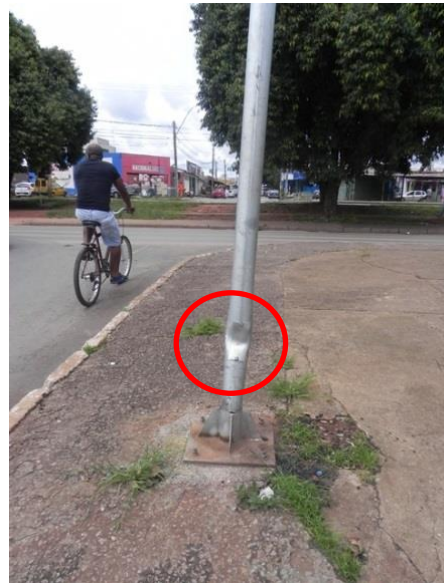
Figura 6 - Poste danificado. Local: Ceilândia, próximo a EQNN 3/5 bl. A.
