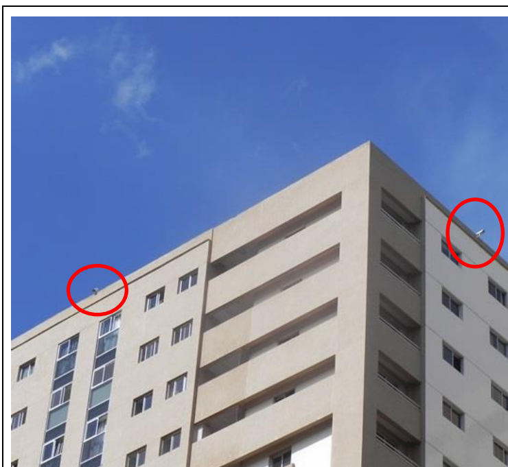
Figura 9 - Instalação de câmera em prédio residencial. Local: Samambaia, próximo à QS 402. Registro fotográfico em 12/2015
