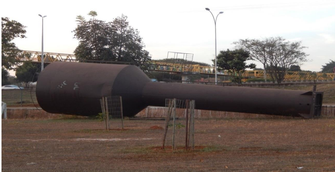
Foto 02 – Reservatório de Água ao lado da pista de saída do Zoológico que deverá ser utilizado para aumentar a pressão dos bebedouros do Parque e reforçar o abastecimento dos recintos de animais de grande porte.
