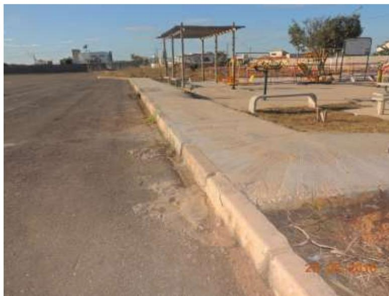
Foto: ausência de acesso à rampa deficiente físico(meio fio)
