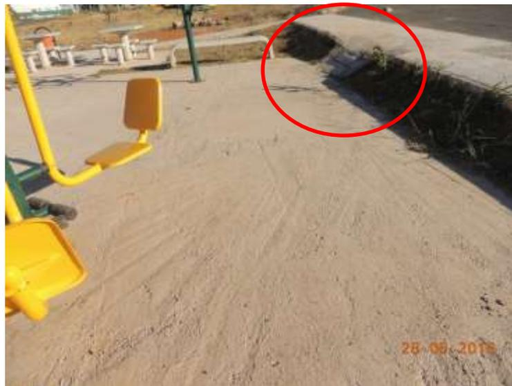
Foto: Rampa em destaque, construída fora do padrão e sem acesso pelo meio-fio
