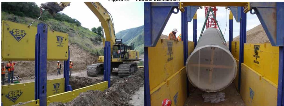
(a) Içamento do painel por escavadeira hidráulica.
