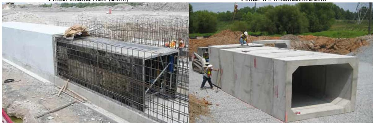
(c) Aduela de concreto armado moldada *in loco*.
