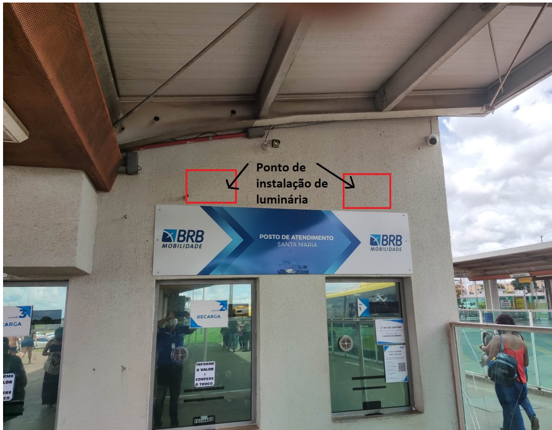
Figura 3 - Posto de Recarga BRT Santa Maria
