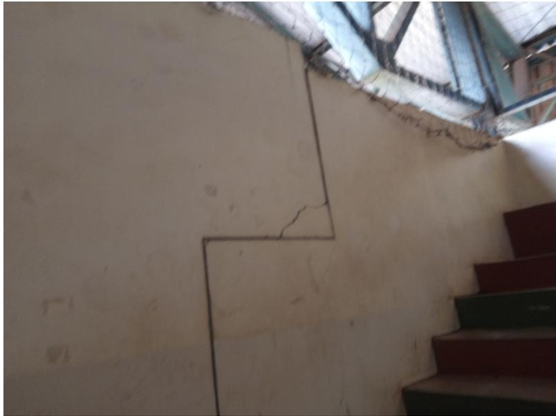
Imagem 7 - Ginásio de Esportes - Rachadura e sujeira próximo a arquibancada
