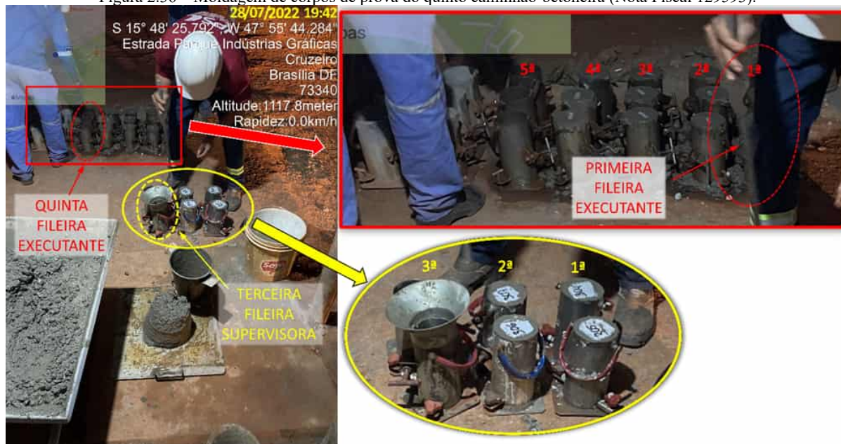
Figura 2.36 – Moldagem de corpos de prova do quinto caminhão-betoneira (Nota Fiscal 129593).
