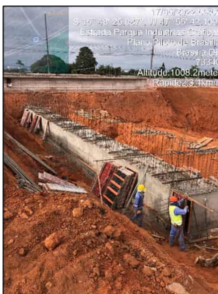
(c) Conclusão da desforma.
