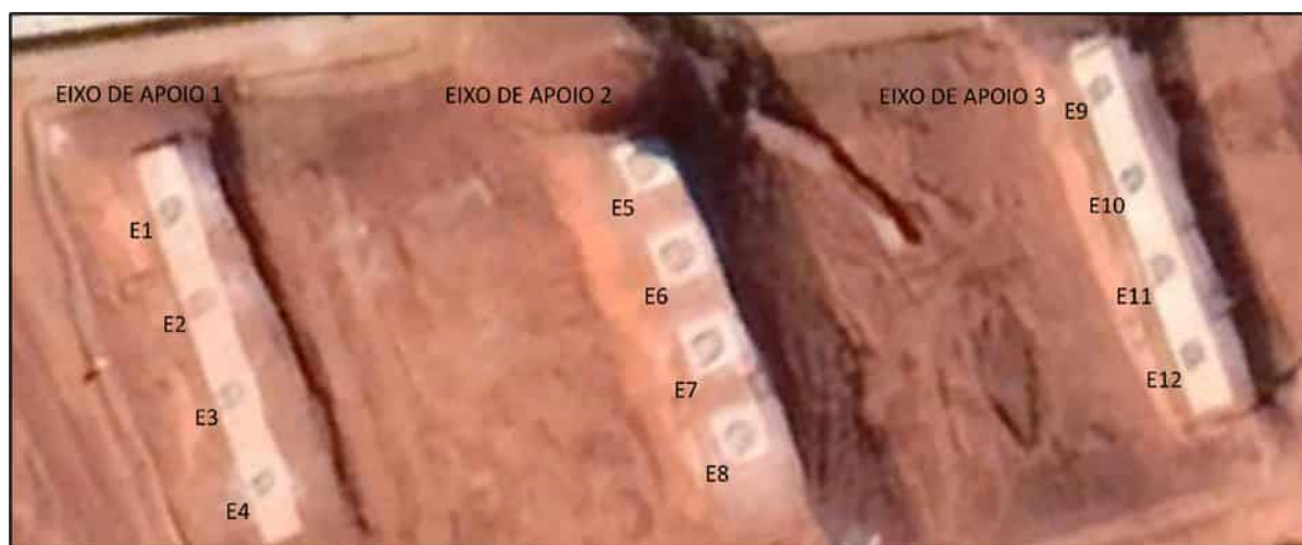
(b) Execução da OAE 8.
