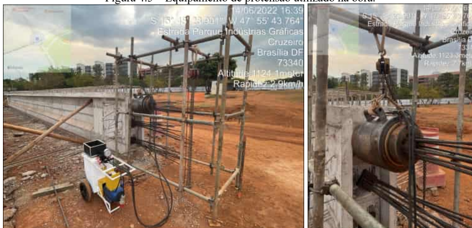
Figura 4.5 – Equipamento de protensão utilizado na obra.
