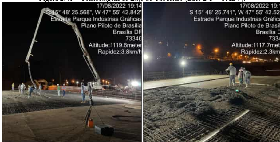
Figura 2.41 – Concretagem da Laje do Tabuleiro (Eixo 2-3 – OAE 9).
