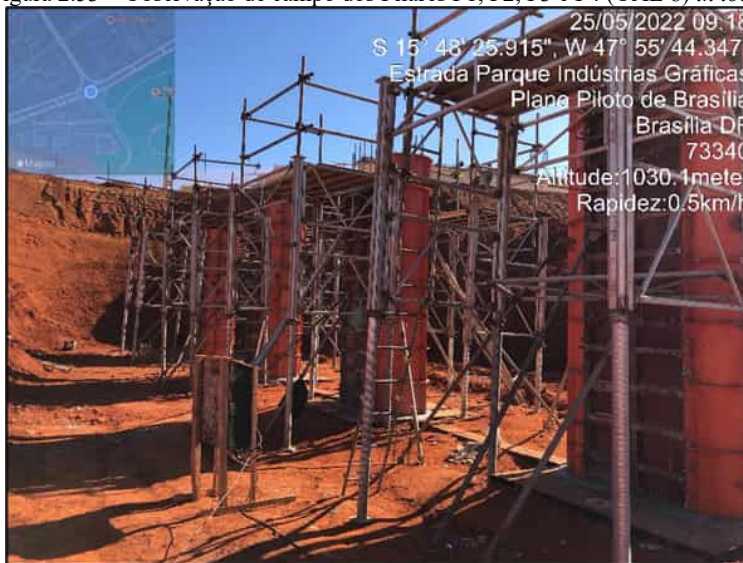
Figura 2.53 – Observação de campo dos Pilares P1, P2, P3 e P4 (OAE 8) in loco .
