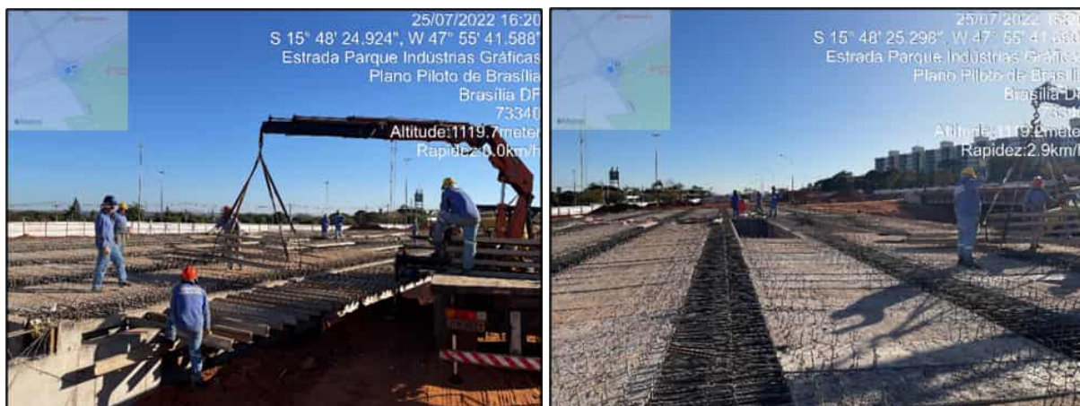
(b) Posicionamento sobre as vigas longarinas.
