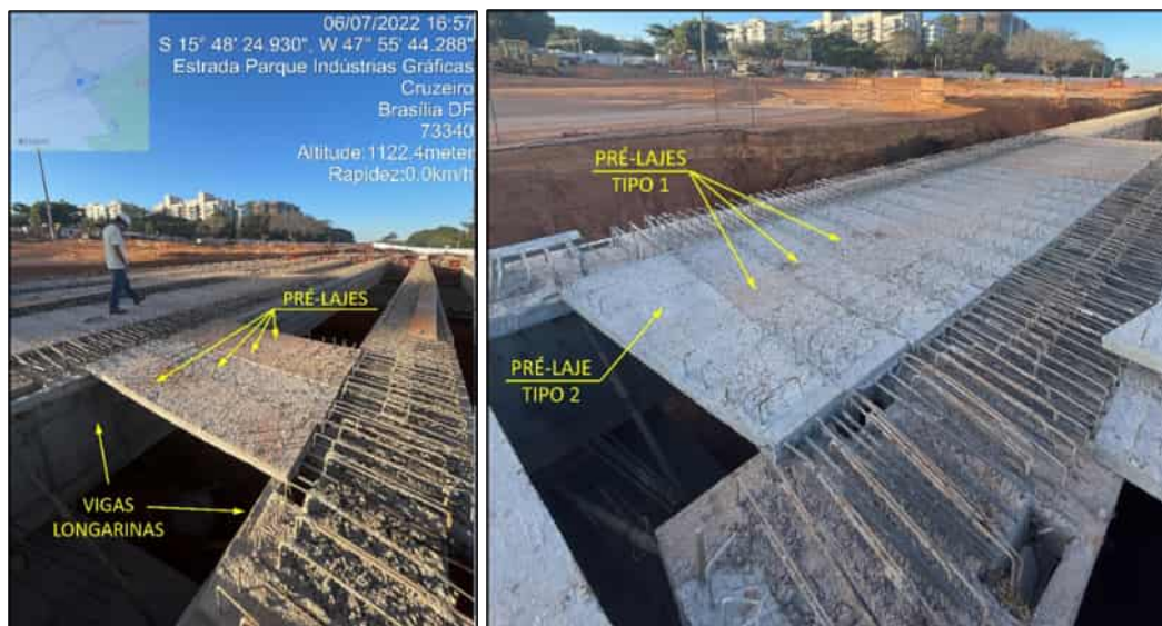
(d) Posicionamento sobre as vigas longarinas.
