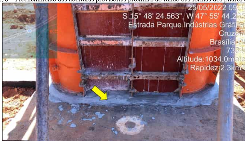
Figura 2.56 – Preenchimento das aberturas provisórias próximas ao fundo das fôrmas dos pilares da OAE 8.
