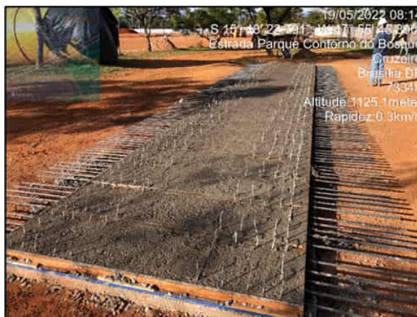
(c) Pré-lajes concretadas.
