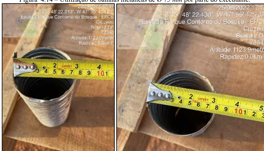
Figura 4.14 – Utilização de bainhas metálicas de \varnothing 75 mm por parte do executante.
