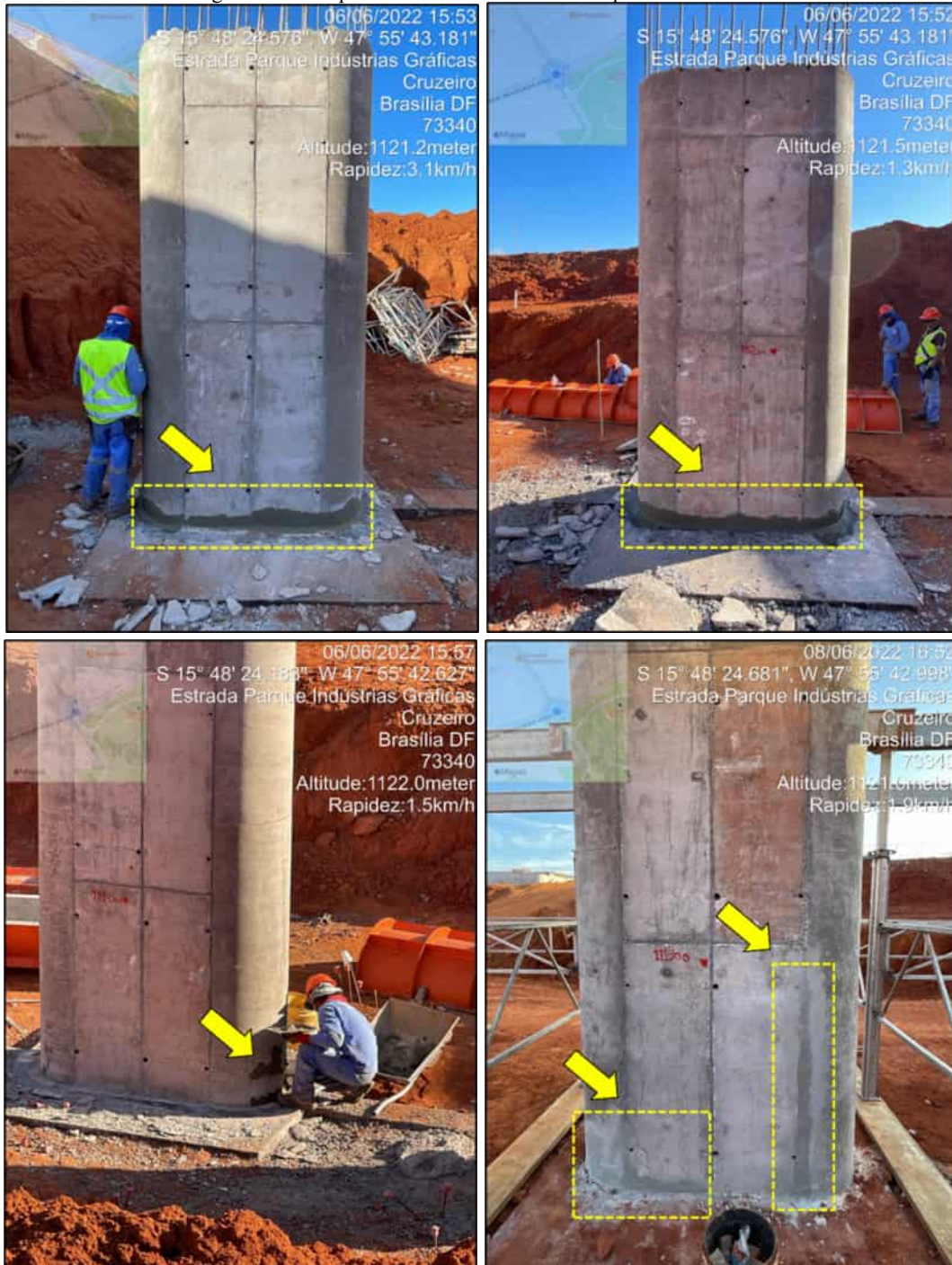
Figura 2.60 – Reparos localizados nas faces dos pilares da OAE 8.
