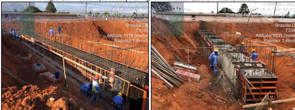
(a) Finalização do sistema de fôrma.
