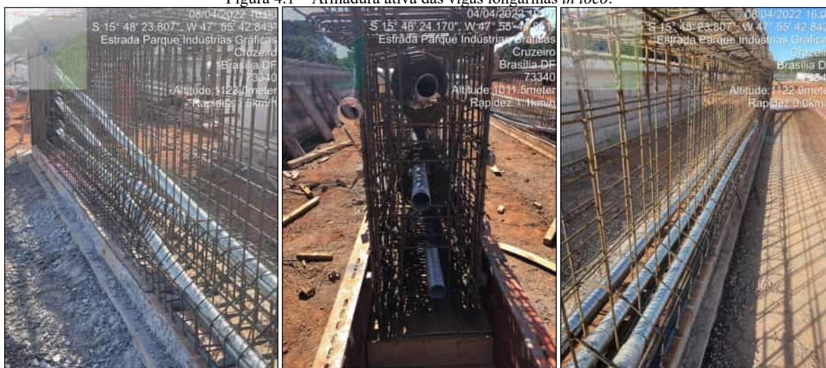
(a) Bainhas na extremidade da viga.
