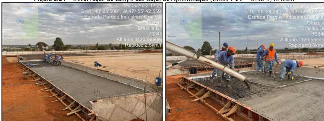
(a) Parte da laje (Eixo 3) a ser concretada.
