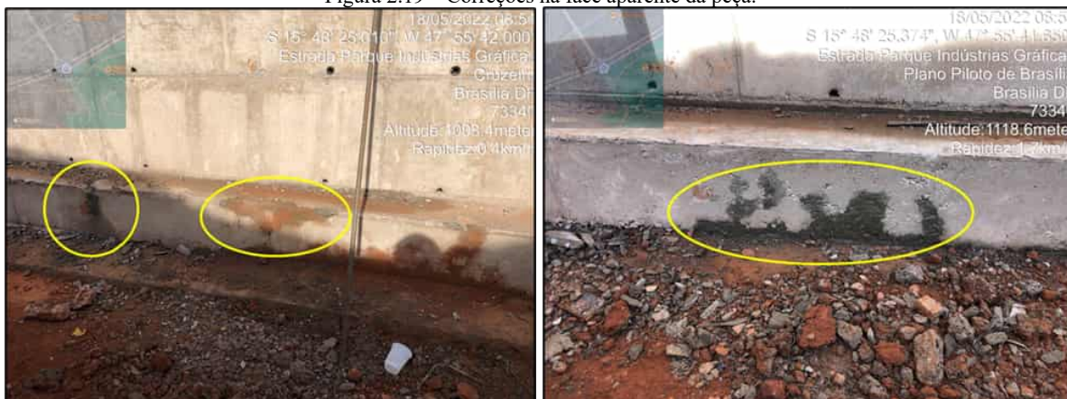
Figura 2.19 – Correções na face aparente da peça.
