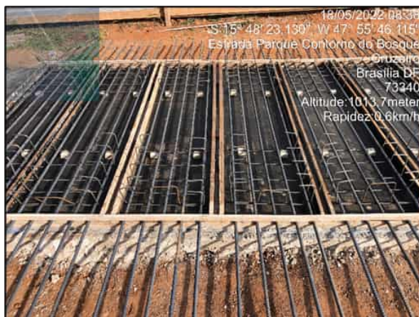
(b) Armadura positiva da laje do tabuleiro.
