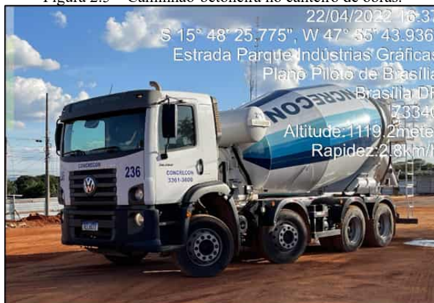
Figura 2.5 – Caminhão-betoneira no canteiro de obras.
