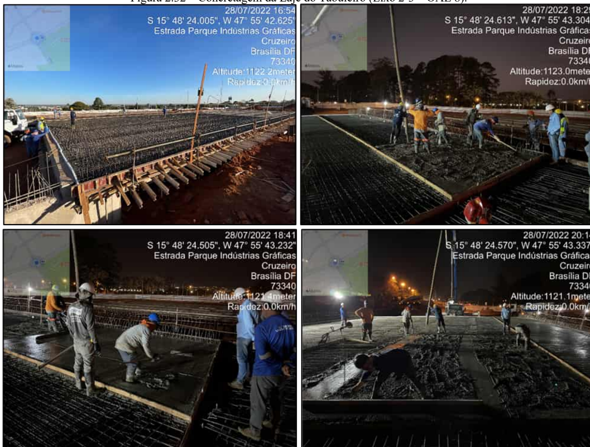
Figura 2.32 – Concretagem da Laje do Tabuleiro (Eixo 2-3 – OAE 8).
