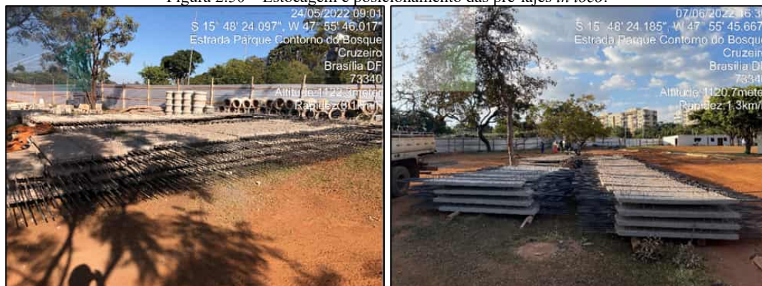
(a) Estocagem no canteiro de obras.
