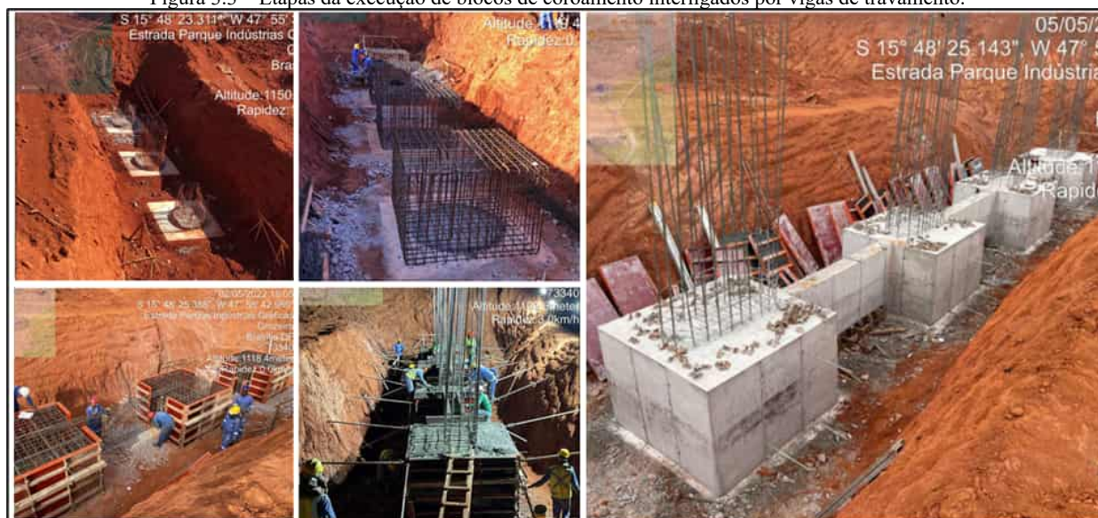
Figura 3.3 – Etapas da execução de blocos de coroamento interligados por vigas de travamento.
