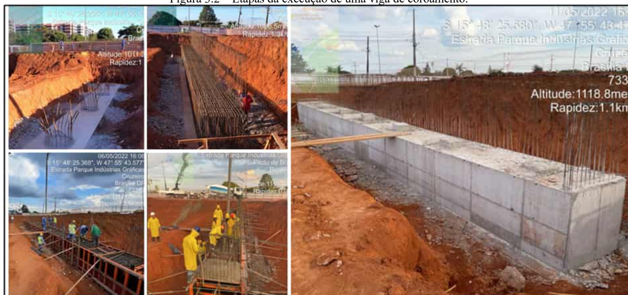
Figura 3.2 – Etapas da execução de uma viga de coroamento.
