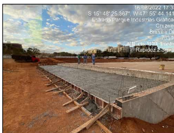
(c) Laje (Eixo 1) já concretada.
