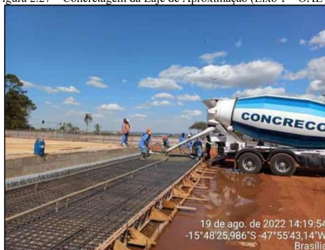
Figura 2.27 – Concretagem da Laje de Aproximação (Eixo 1 – OAE 9).
