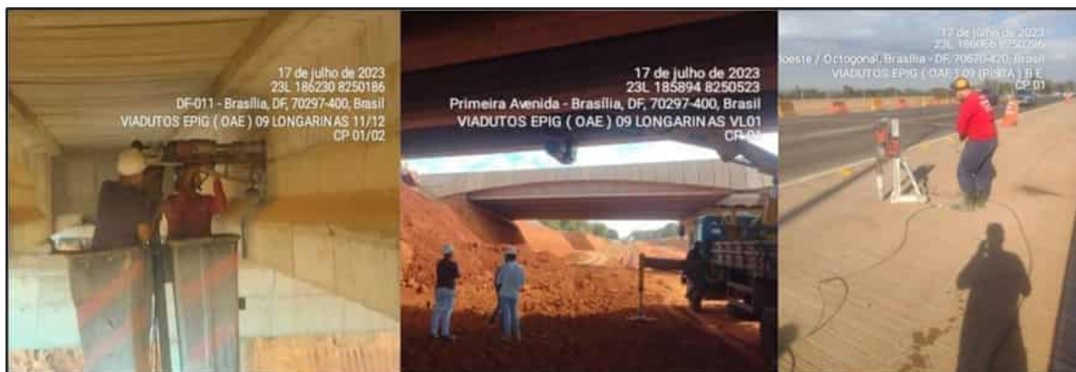
(d) Viga Longarina VL12 da OAE 9. (e) Viga Longarina VL1 da OAE 9. (f) Laje do Tabuleiro da OAE 9.
