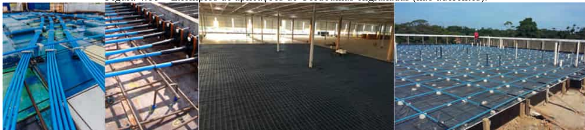
Figura 4.10 – Exemplos de aplicações de Cordoalhas engraxadas (não aderentes).
