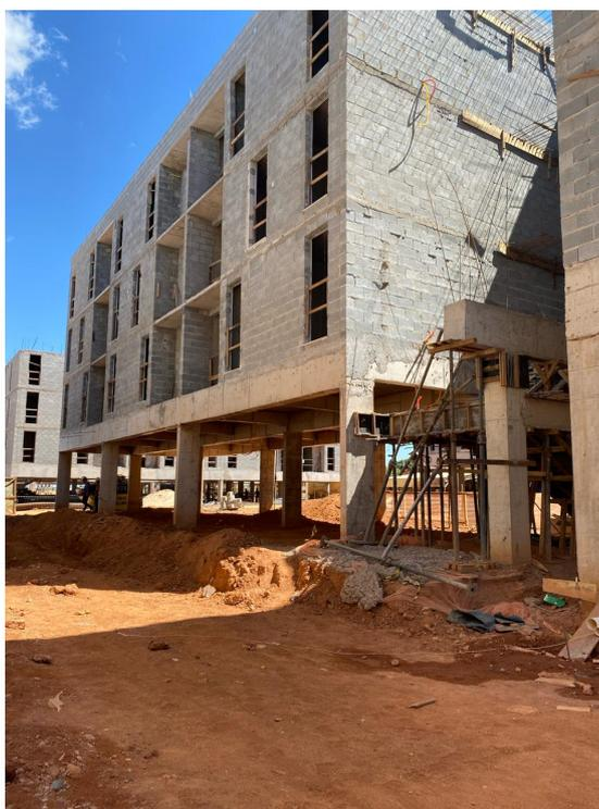
Figura 2 - Estrutura em concreto armado e fechamento externo com bloco de concreto.
