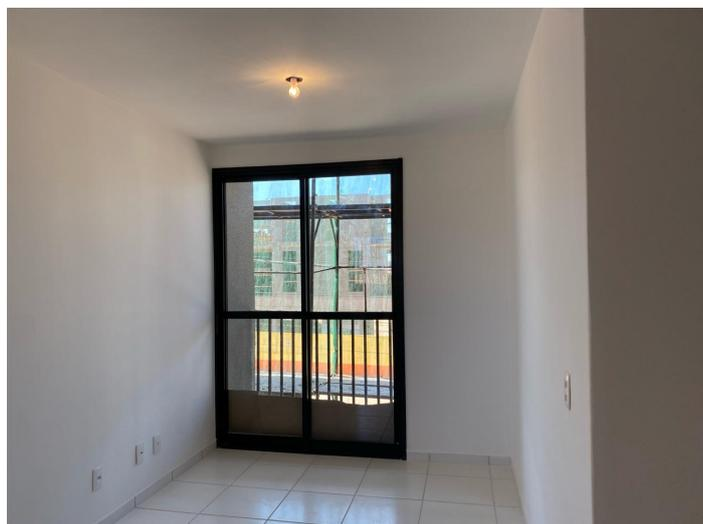
Figura 5 - Esquadrias metálicas com vidro temperado
