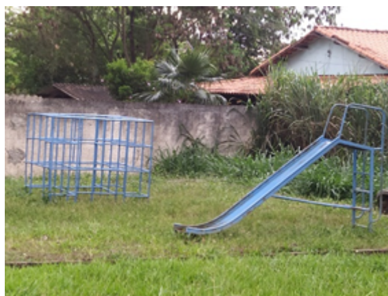
Vargem Bonita - Parque Infantil sem manutenção
