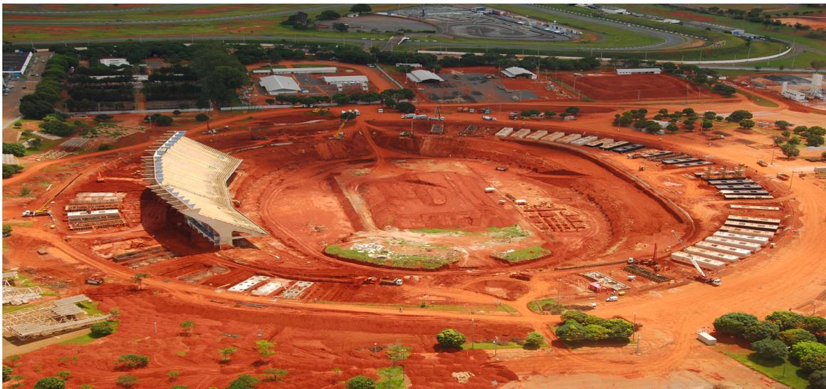
**VISTA AÉREA DO ESTÁDIO APÓS A DEMOLIÇÃO DA ARQUIBANCADA SUPERIOR.**
