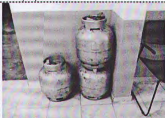
Fig. 3 – botijões de gás estocados na sala de almoxarifado
