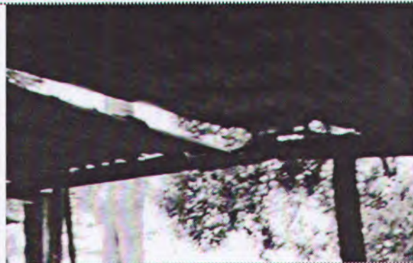
Fig. 6 – Telhas quebradas
