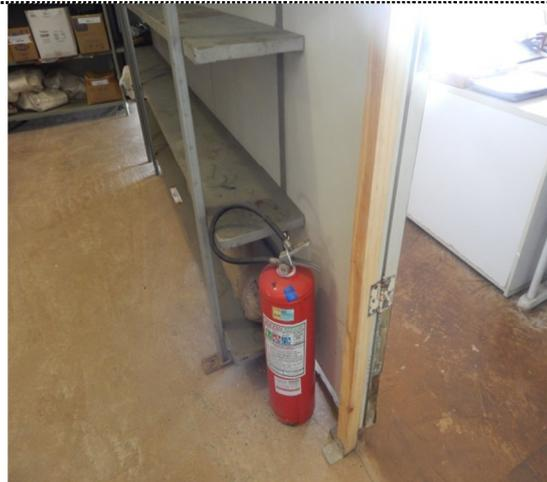
Fig. 2 – Ausência de sinalização vertical e horizontal de localização de extintores de combate a incêndios
