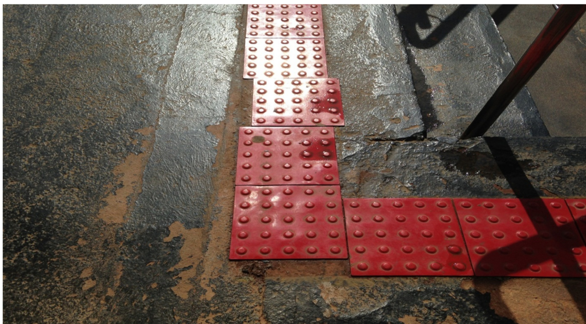
Fotografia 4 – Dano em Instalação Decorrente de Infiltrações
