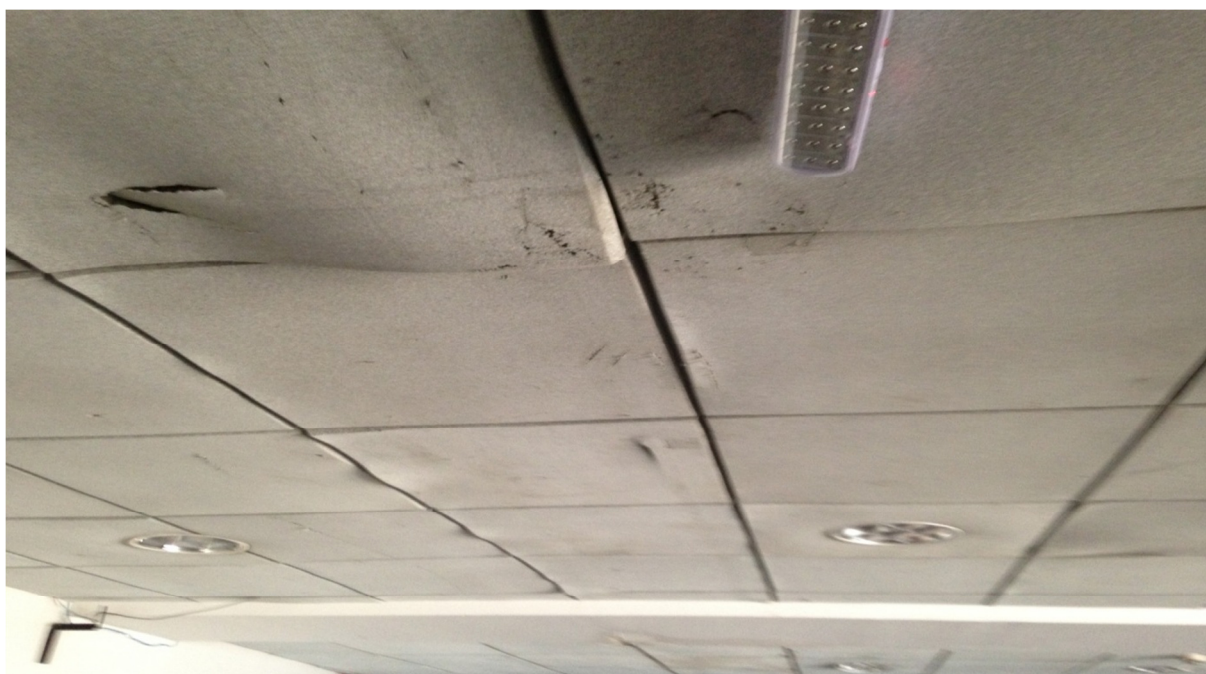
Fotografia 4 – Dano em Instalação Decorrente de Infiltrações
