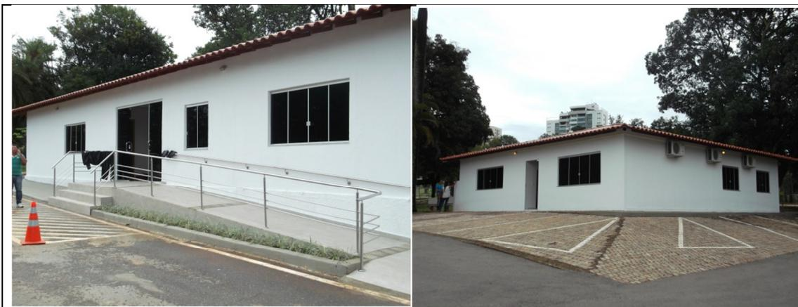
**FIGURA 1 - CORRIMÃO E GUARDA CORPO DE TUBO/AÇO GALVANIZADO ENTREGUE COM METRAGEM A MENOR NA CASA DA ADMINISTRAÇÃO (Esquerda) E NÃO FORNECIDO PARA A CASA DA SEGURANÇA DA ROAC (Direita)**
