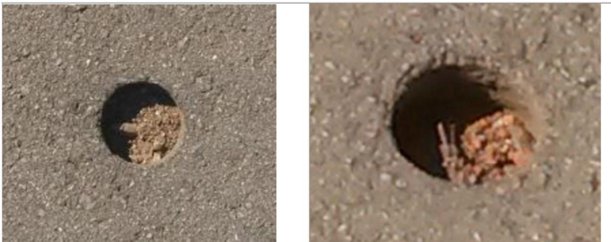
Observou-se também que os furos resultantes das extrações das amostras não foram preenchidos com massa asfáltica (Figura 23). O não preenchimento desses furos prejudica a vida útil do pavimento, pois a água de chuva penetra facilmente nas camadas inferiores do pavimento, acelerando o processo de degradação das camadas.
