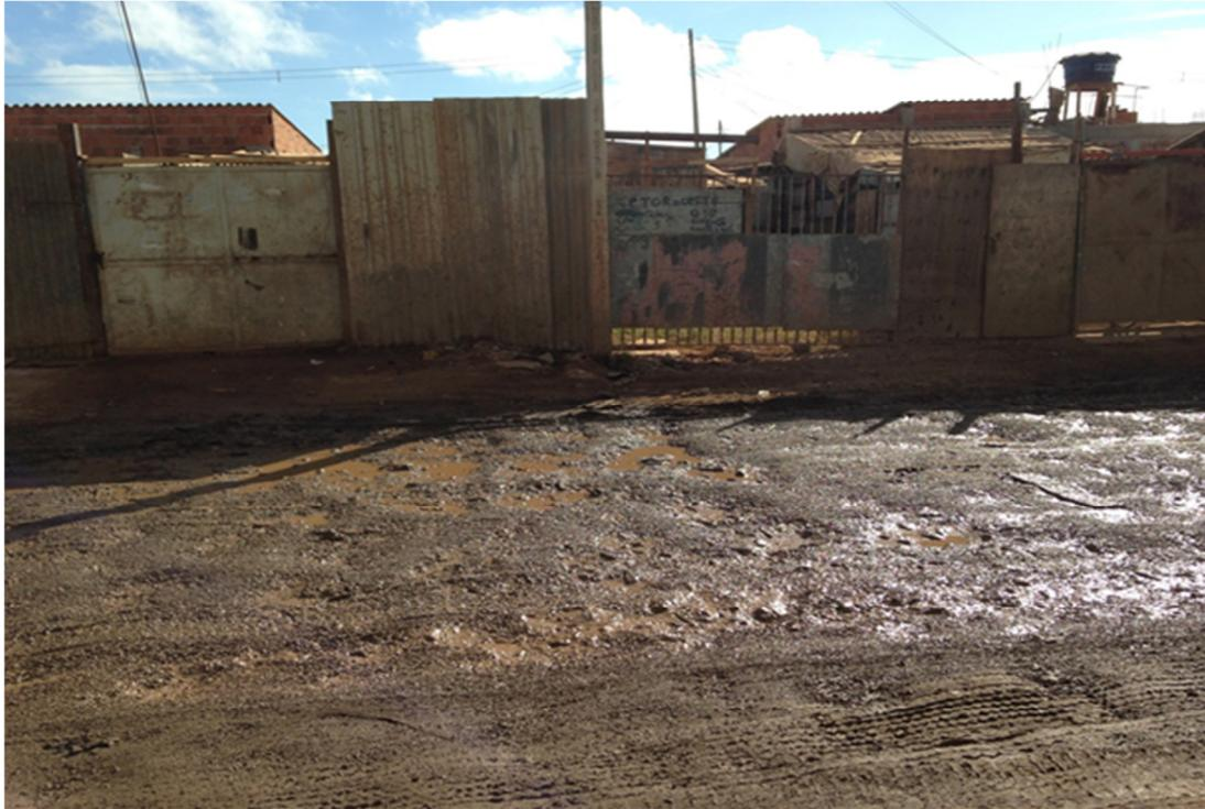
Fotografia 4 - Pavimentação completamente deteriorada - Data 25/06/2015
