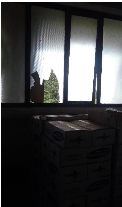
Vidro quebrado no almoxarifado central
