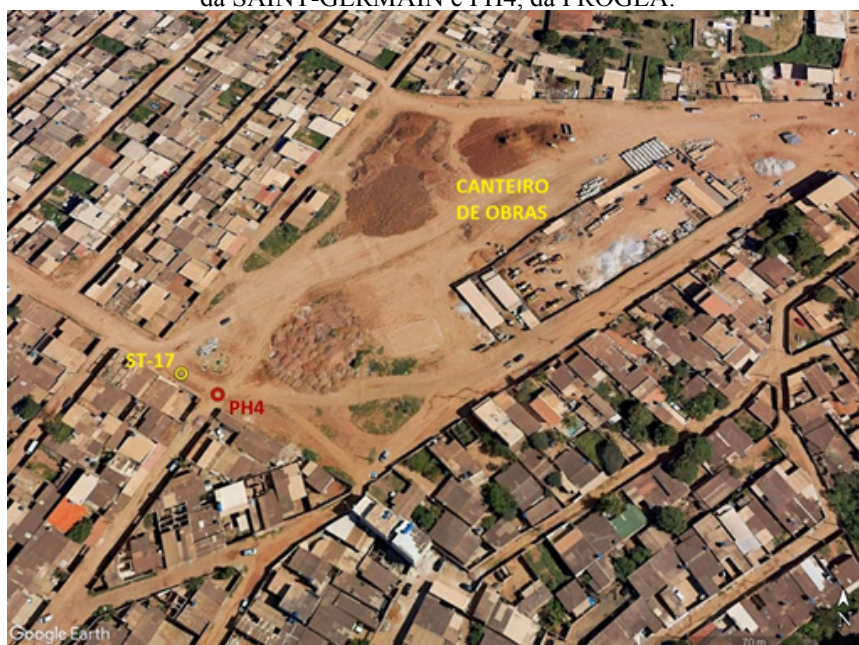
Figura 1.1.9 - Localização, para fins de comparação, entre os pontos ST-17 (Trecho 2, Rede de Drenagem) da SAINT-GERMAIN e PH4, da PROGEA.
