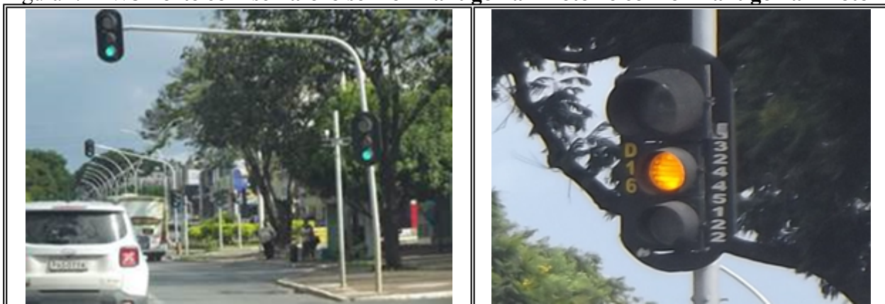
Figura 7 - W3 norte com semáforo sem o nº antigo na 1ª foto* e com o nº antigo na 2ª foto
