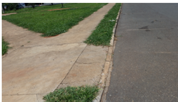
Foto 2: Rampas de acessibilidade em desacordo com a norma vigente da ABNT 9050:2015.
